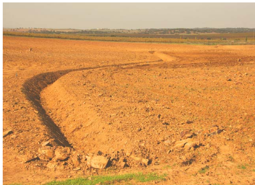
Vala de drenagem aberta á superfície no T082. Foto: Esporão.
